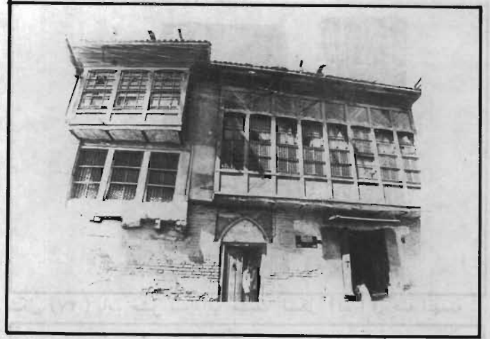
شكل (٣٠) غرفة معلقة من الخشب تبدو كأنها غرفة واحدة مع شناسيل خشبية .
